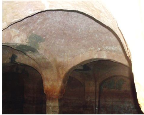
اللوحة (٧) قبة ضحلة مستديرة المسقط اللوحة (٨) الباحث وهو يقوم بعملية قياس الصهريج
